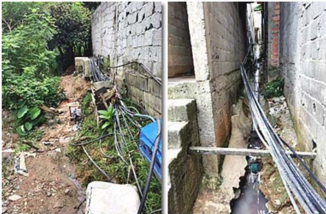
Figura 2: Foto de emaranhado de tubulações em área irregular. (UGR Guarapiranga)
